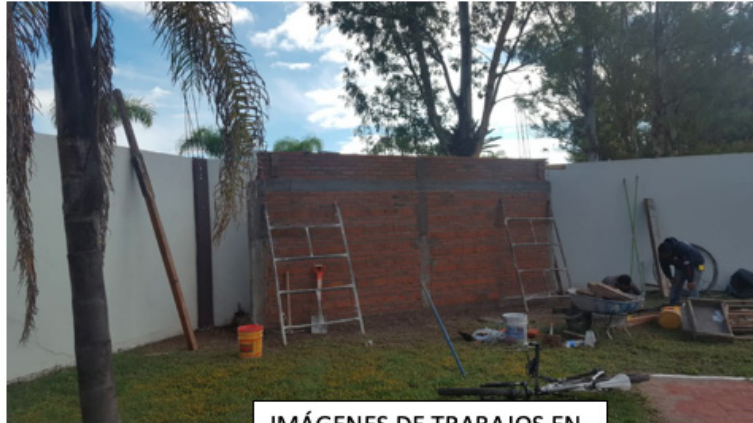
IMÁGENES DE TRABAJOS EN PROCESO
